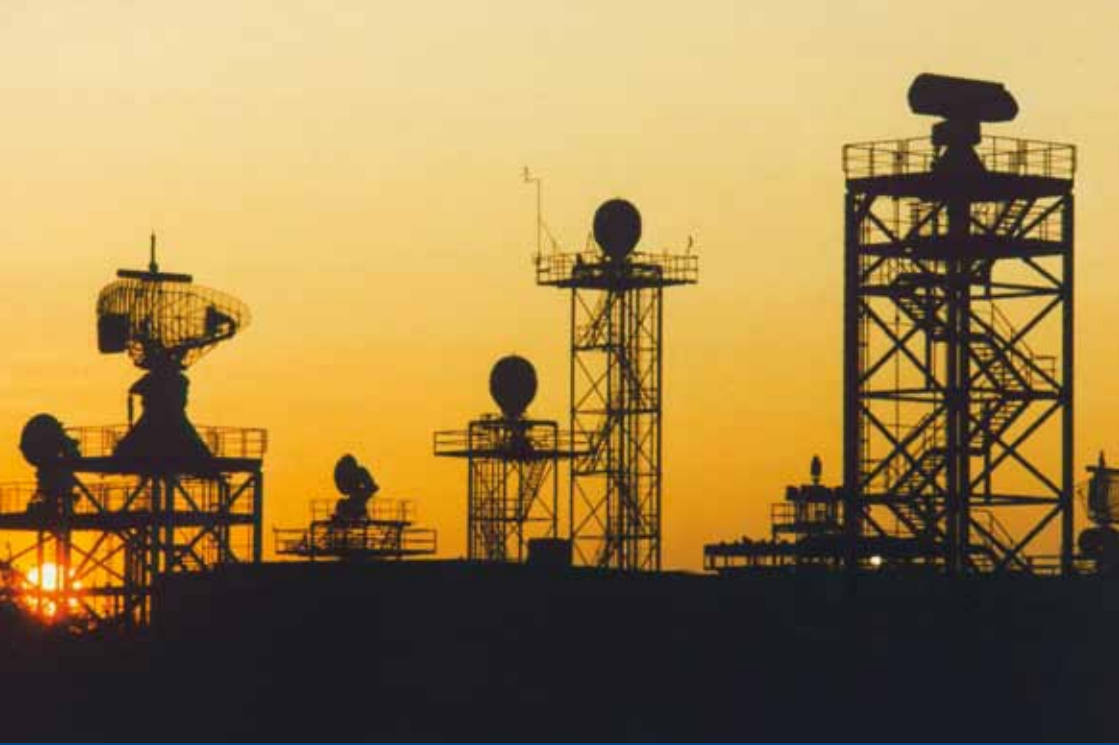
Radargeräte der Test- und Referenzanlagen beim Kommando Marineführungssysteme, Wilhelmshaven Radars of the Test centre at the Naval Command and Control Systems Command, Wilhelmshaven
