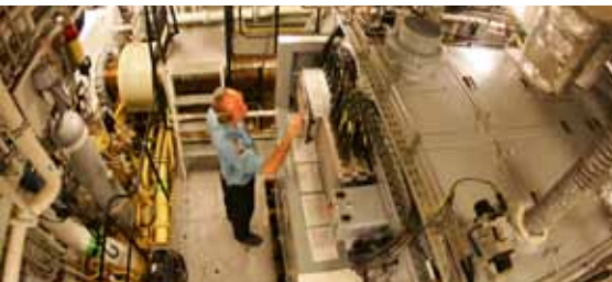
Im Maschinenraum der Fregatte HESSEN SACHSEN-class engine room
